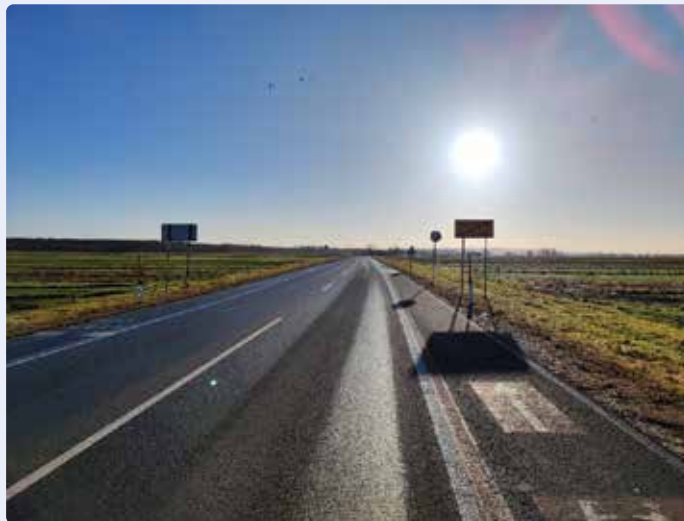
12. kép: Kialakított kétirányú kerékpársáv az R2-442/1319 Dobronak-Hosszúfalú körforgalom állami regionális úton – nagyobb biztonság és kényelem a kerékpárosok számára
