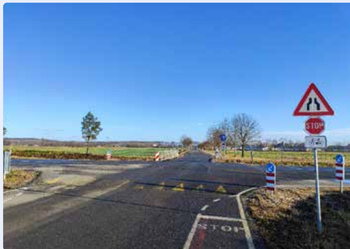
14. kép: Kialakított, szintkülönbséget biztosító kereszteződés a forgalom lassítására és a kerékpárosok és gyalogosok biztonságának növelésére az LC-430031 Turnišče–Dobronak kereszteződésben a JP-707651 Radamosi csatorna–kavicsbánya községi közúttal
